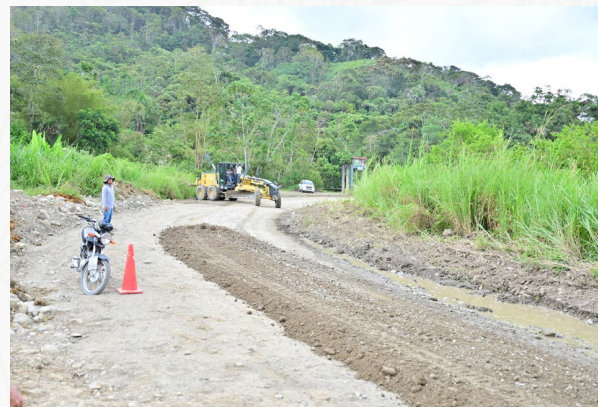
Vía antigua Sevilla (3,36 Km)
