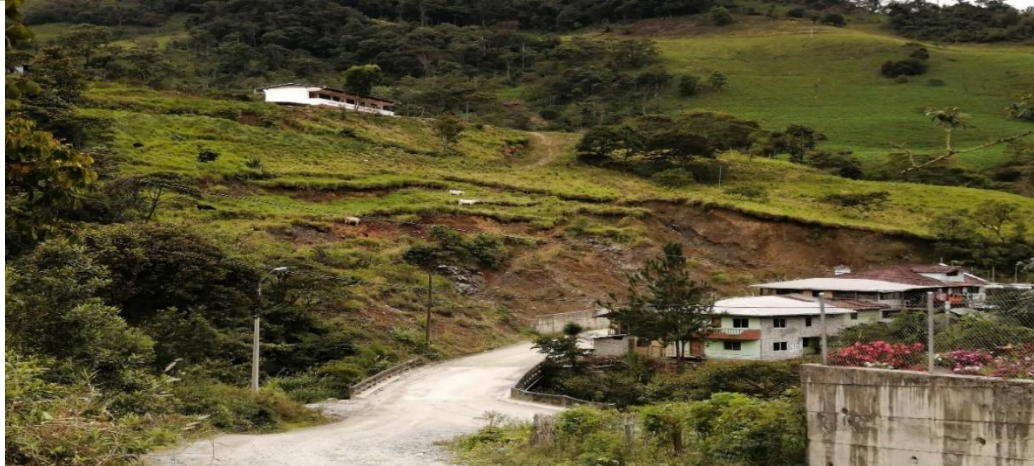
PRESENCIA DE MOVIMIENTO CON UN RIESGO EMINENTE A LA POBLACIÓN E INFRAESTRUCTURA
