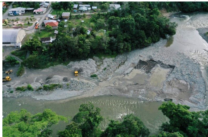
LECHO DEL RIO CERCA A LA POBLACIÓN CONSOLIDADA Y LAS VIVIENDAS
