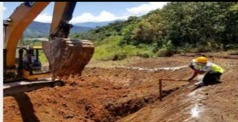
**CONSTRUCCIÓN DE TALUDES Y VERIFICACIÓN EN SITU DE SU PROPORCIÓN H:V**
