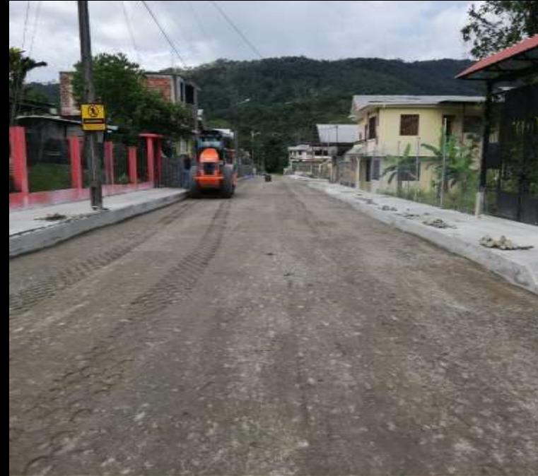
**TRABAJOS PREVIOS AL ADOQUINADO DE LAS CALLES DEL BARRIO SAN JOSE** - Preparación de las vías del Barrio San José previo al adoquinado (comprende: excavaciones, desalojos y reposición de material con material de mejoramiento sub-base y base granular), incluye la explotación y minado de pétreos, transporte, tendido y compactación de la rasante de la vía.
