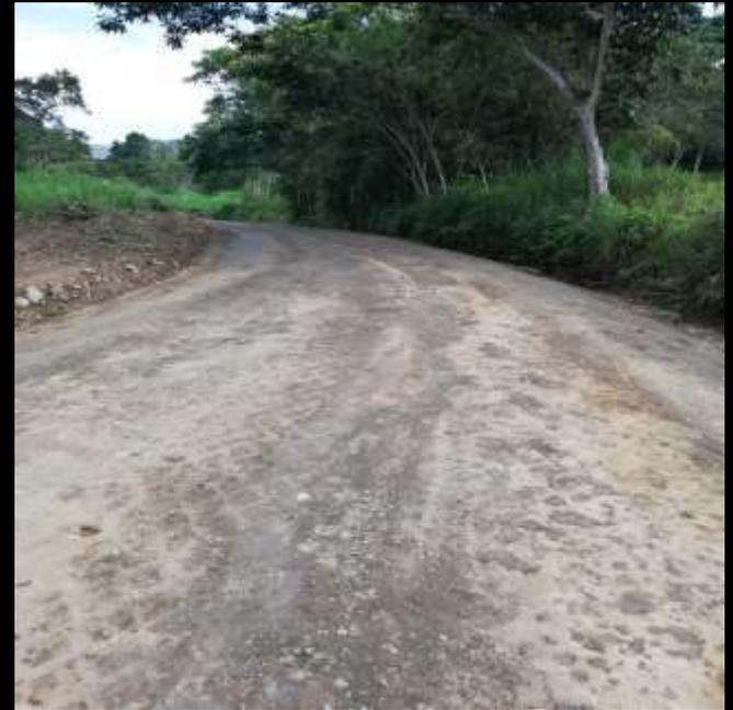
**TRABAJOS DE MANTENIMIENTO DE LA VIA CON REPOSICION DE MATERIAL DE MEJORAMIENTO (SUBBASE DE RIO) TRAMO TRONCAL AMAZONICA- ROLDOS- INCLUYE TRAMO A KENKUIM (L= 6 KM).**
