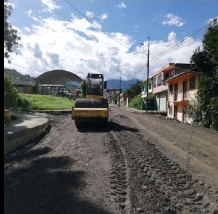
**TRABAJOS PREVIOS AL ADOQUINADO DE LAS CALLES DEL BARRIO LA UNION.** (Comprende: excavaciones, desalojos y reposición de material con material de mejoramiento sub-base y base granular), incluye la explotación y minado de pétreos, transporte, tendido y compactación de la rasante de la vía
