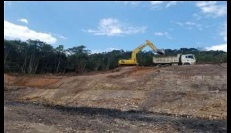
TRABAJOS EN " CELDA B" DE RELLENO SANITARIO (EXCAVACION Y DESALOJO DE MATERIAL POR OCACIONARSE FALLA GEOLOGICA)
