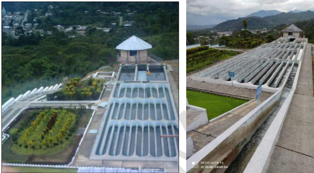
Imagen 2 Planta de Tratamiento de Agua Potable
