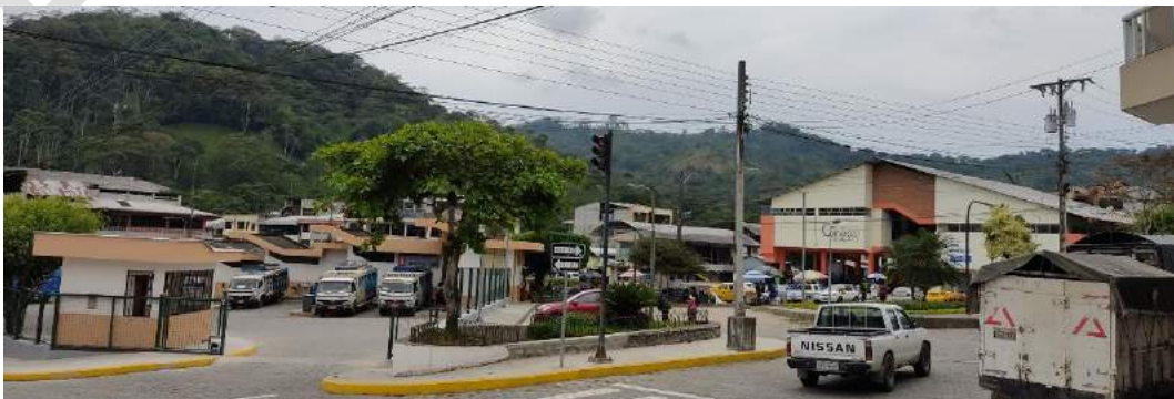
Foto 1.4: Conflictos entre equipamientos
