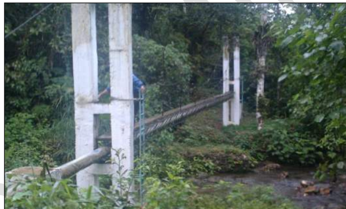
Foto 1.2. Conducción Yumaza, paso elevado sobre el Río Yumaza.
