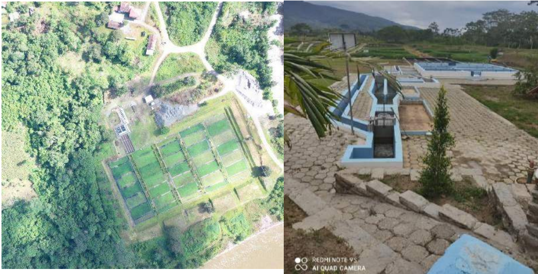
Imagen 3 Planta de Tratamiento de Agua Residuales
