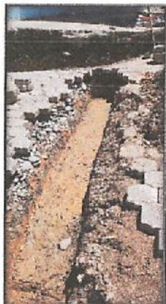
EXCAVACIÓN PARA REJILLA
