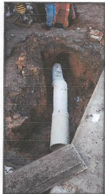
INSTALACIÓN DE SIFÓN
