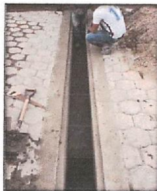
HORMIGÓN EN CANAL
