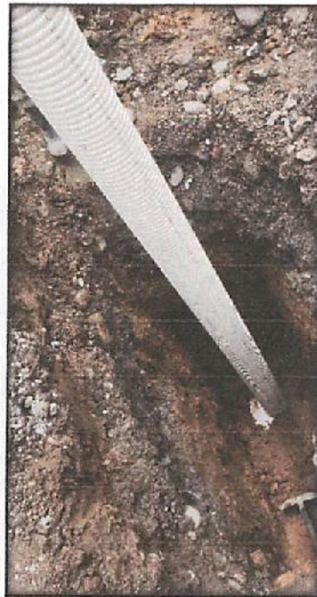
INSTALACIÓN DE TUBERÍA EN SUMIDERO 1
